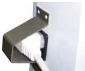
Fig. 10. Beskyttelse over karmvarmestøpselet
