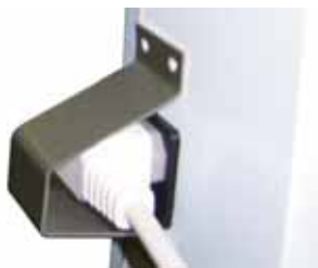
Bild 10. Skydd av karmmotståndets kontakt
