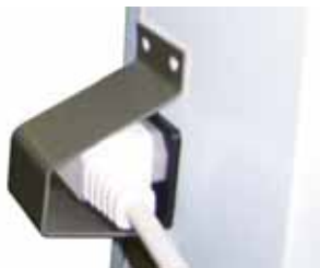
Tekening 10: Deurkader weerstand stekkerbescherming
