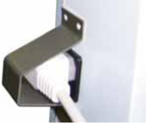
Fig. 10. Karmvarmestik og -kabel med beskyttelsesdækplade.
