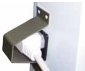
Kuva 10. Karmivastuksen kaapeli ja suojuks
