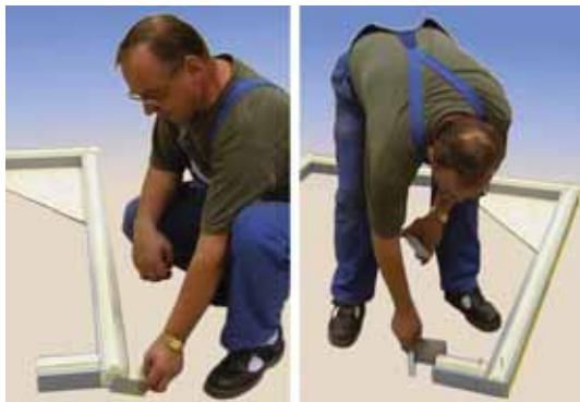
Photo 5. Plaques de recouvrement des angles
